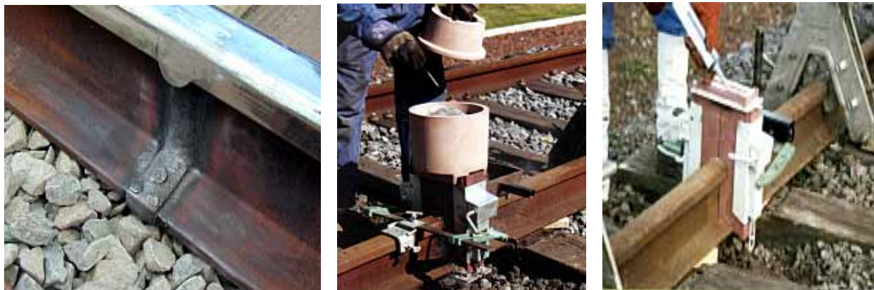
شکل ۲ - جوش درز ریل [۱۱، ۹]
