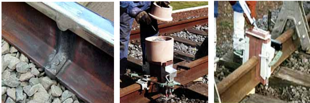
شکل ۲ - جوش درز ریل [۱۱، ۹]
