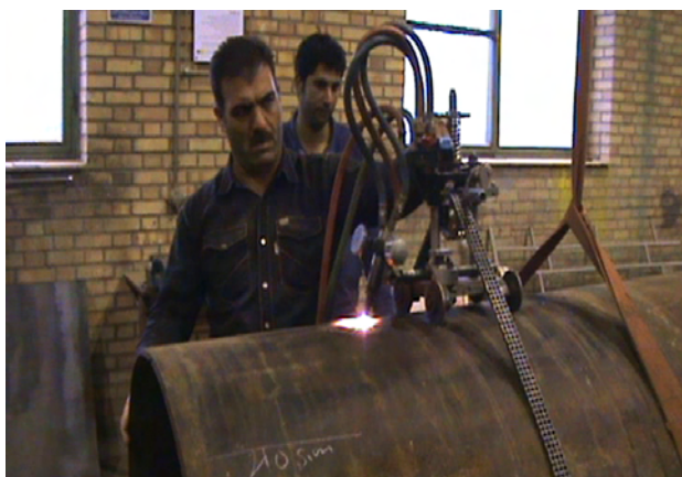
شکل ۱- برش کاری لوله
