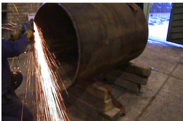
شکل ۲- آماده سازی لوله
