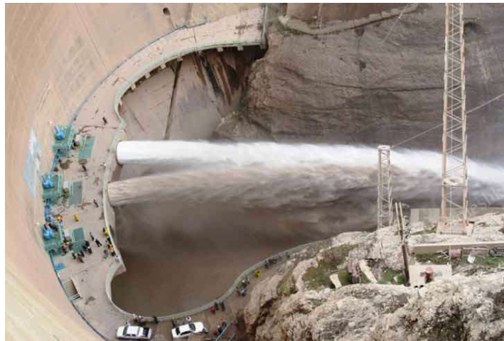
شکل ۱. تخلیه کننده‌ها در زمان باز شدن جهت رسوب‌شویی تحت فشار (سد دز- خوزستان)
