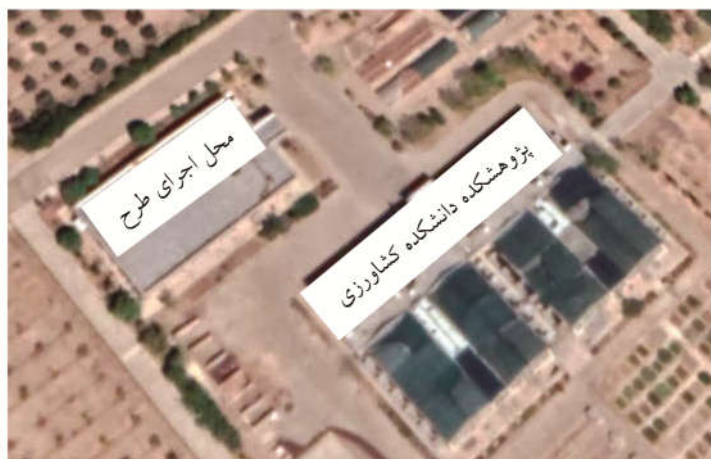
شکل ۱. نقشه هوایی از محل اجرای طرح
