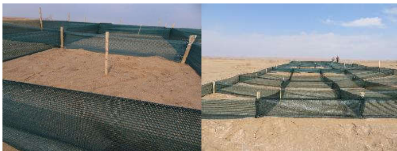
شکل ۲. احداث بادشکن توری و نصب شاخص چوبی
