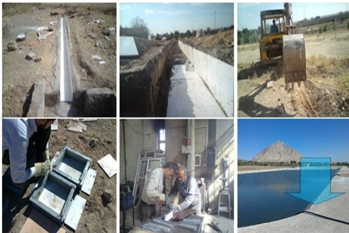
شکل ۳. مراحل گودبرداری، تهیه قالب بتن، عایق‌بندی کانال و تنظیم جریان ورودی به کانال
