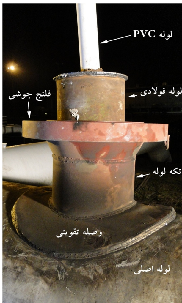
شکل 2 - تجهیزات بکاررفته در عملیات تعمیر نشتی
